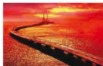
monitorización de estructuras
