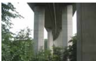
ensayo de construcción
