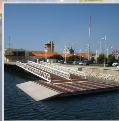
Puentes de Acceso y Rampas
