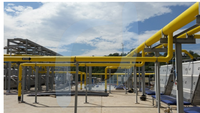
Tuberías para Desodorización en la EDAR de Atotonilco (México)
