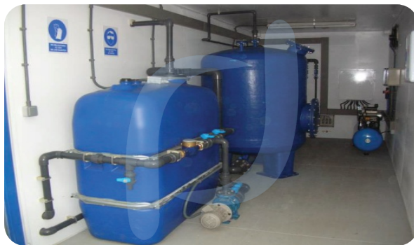
Inerco – 3 Equipos de filtración y bombeo 240 m 3 /día
