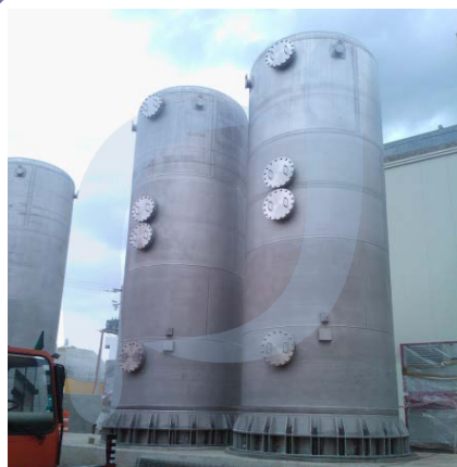
Filtro de Carbón Activo en la EDAR Atotonilco (México)
