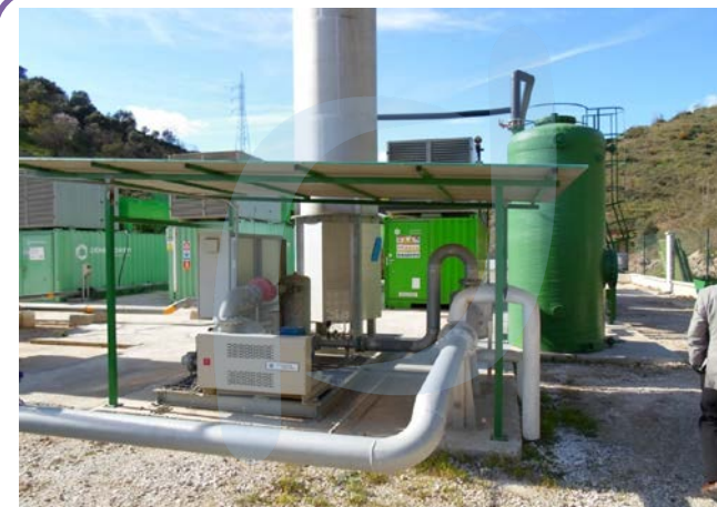
Equipos de Tratamiento de Siloxanos y COVs - Málaga
