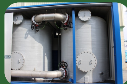
Limpieza y acondicionamiento de Biogás en Contenedor
