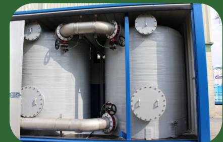
Limpieza y acondicionamiento de Biogás en Contenedor
