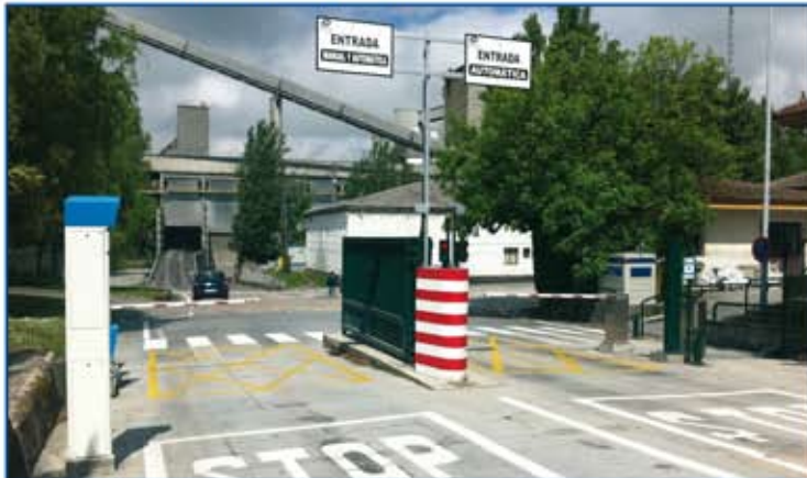
Control de acceso con RFID y lectura de matrícula Grupo Cimpor
