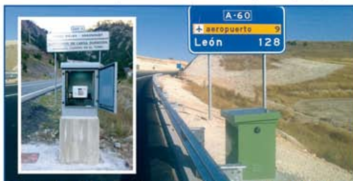
ETD de aforo M. Fomento en A60 y aforo en el tunnel de Bielsa
