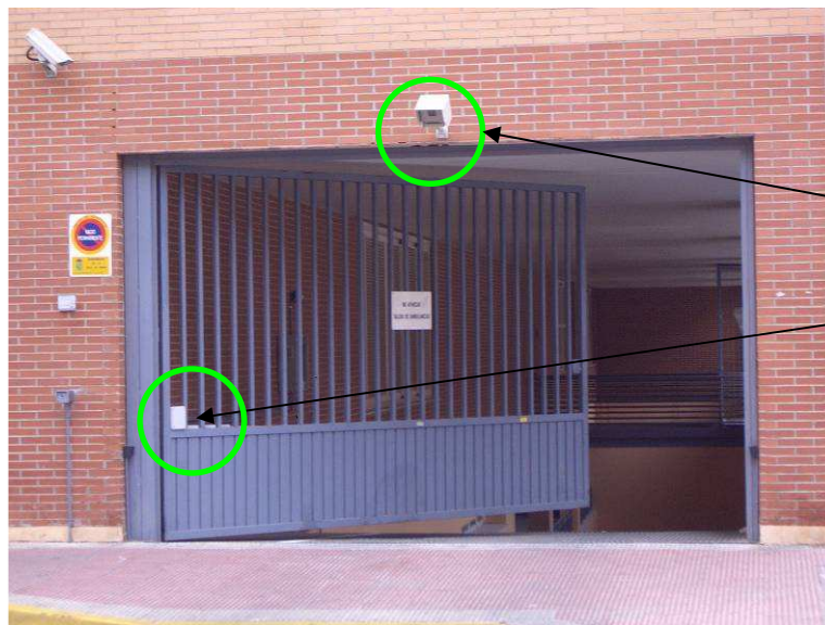
DETALLE PUERTA DE ACCESO EQUIPADA CON CÁMARA DE CAPTURA DE MATRÍCULAS Y APERTURA POR TARJETA DE PROXIMIDAD PARA ACCESO PEATONAL
