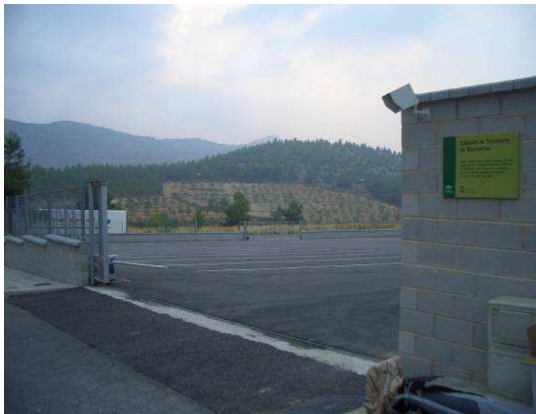
DETALLE PUERTA DE ACCESO Y AL FONDO SALIDA, AMBAS EQUIPADAS CON CÁMARAS DE CAPTURA DE MATRÍCULAS
