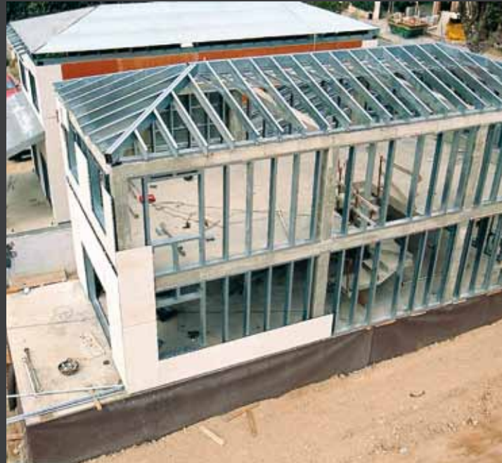
Rehabilitación de un edificio en la Plaza Francesc Macià de Barcelona: tubular pasante de 50 x 20 cm.
