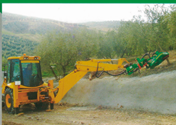
Vibrador en brazo de retroexcavadora.
