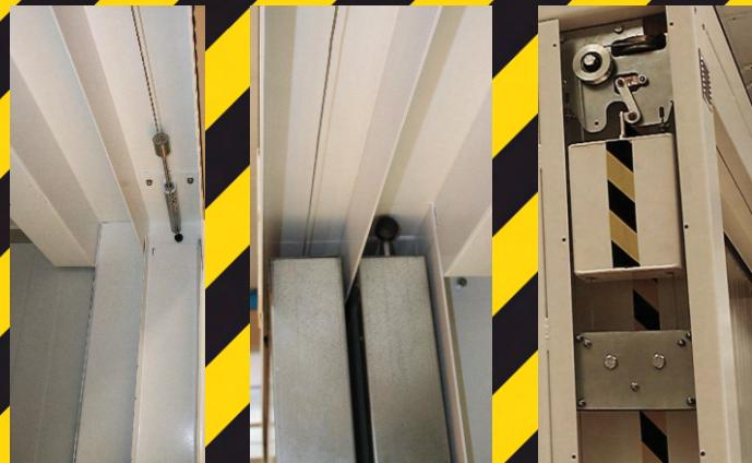
Sistema de freno fin de carrera que evita golpes, y aprisionamientos por el cierre de las puertas automáticas.
