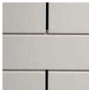
Junta de tope abierta
