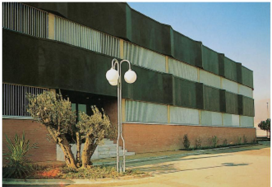
La celosía GRADPANEL 80 está compuesta por lamas tubulares de aluminio con una aleación especial y cubiertas con pinturas termoendurecidas, lo que lo convierte en un sistema altamente resistente a la intemperie y las inclemencias meteorológicas.
