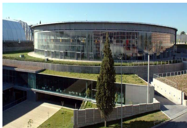
Obra: Construcción Madrid Arena. Dirección: Estudio de arquitectura Cano-Lasso Constructora: FCC-ACS-ORTIZ Construcciones
