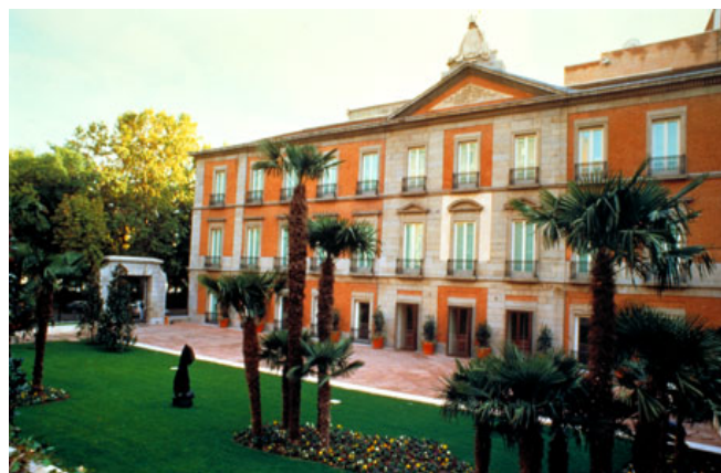
Obra: Ampliación Museo Thyssen Bornemisza. Dirección: Estudio de Arquitectura Bopbaa. Constructora: Ferrovial-Agroman
