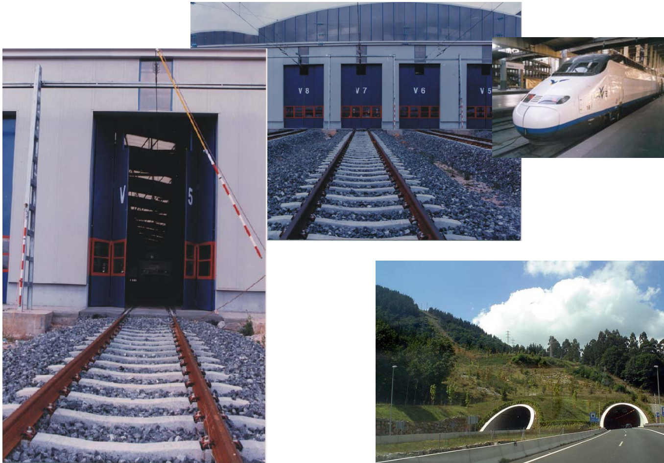
Obra: Hangares Ave Villaseca de la Sagra. Constructora: Vías y Construcciones.
