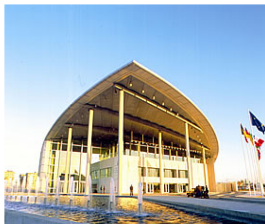
Obra: Palacio de Congresos de Valencia. Dirección: Norman Foster. Constructora: UTE Dragados-NECSO.
