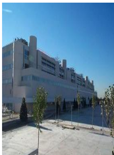
Obra: Hospital de Fuenlabrada Ingeniería: UTE Acciona-Dragados
