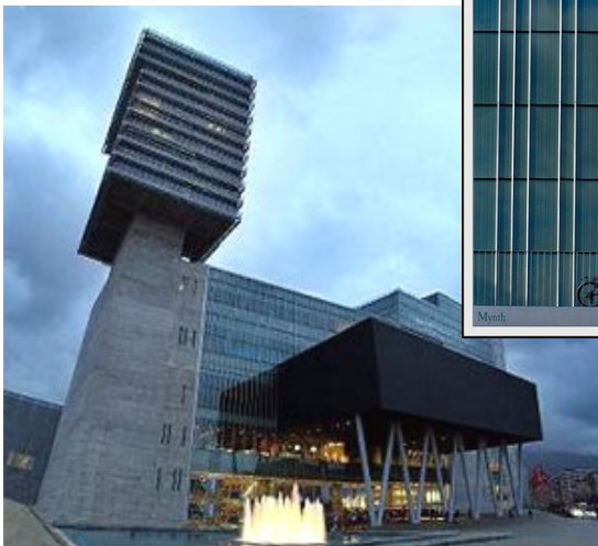
Obra: Feria de Bilbao Constructora: Acciona Dirección: Esteban Rodríguez Soto y César Azcárate Gómez
