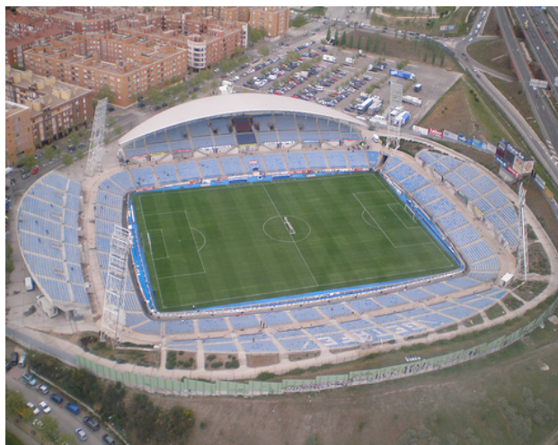
Obra: Construcción Coliseum Alfonso Pérez. Constructora: UTE FCC-NECSO
