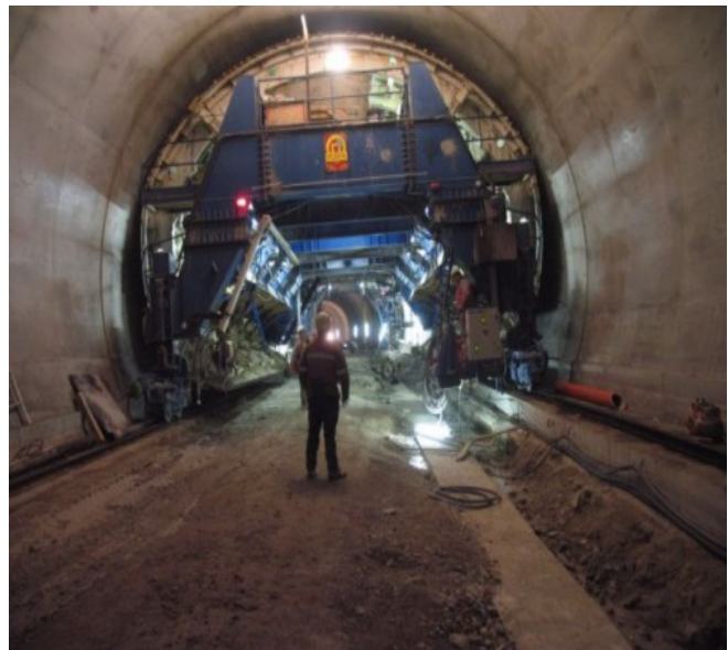
Obra: Túneles en Servia-Montenegro Ingeniería: Indra Sistemas
