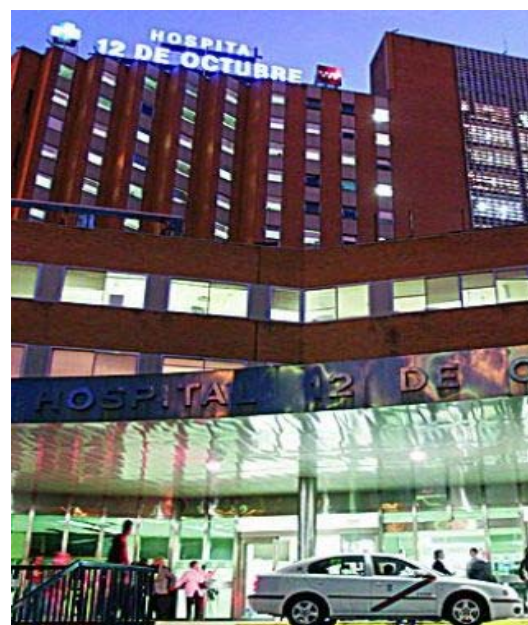
Obra: Hospital 12 de Octubre Constructora: OHL
