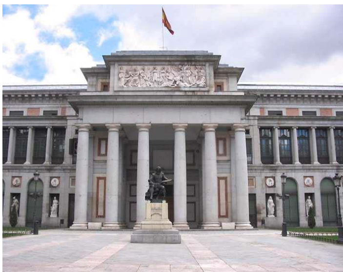
Obra: Ampliación Museo del Prado. Dirección: Antonio Lamela. Constructora: UTE Dragados-Constructora San Jose.
