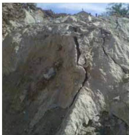
Uso de cemento expansivo para fragmentación
