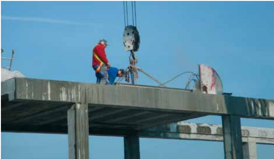
Corte de hormigón con disco diamantado
