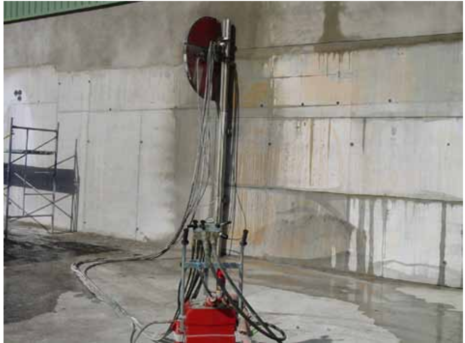
Apertura de huecos mediante corte mural
