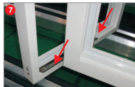
La fijación final del compás en el lado marco tras la adecuada regulación
