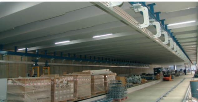
LECHE PASCUAL. ALMACÉN LOGÍSTICO. Burgos. Sobrecarga de 2.000 kg/m 2 con 16 m de luz.
