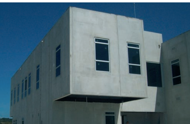
EDIFICIO DE CONTROL ADIF. Orense. Voladizos de 3 m en fachada resueltos con Artlum 60.
