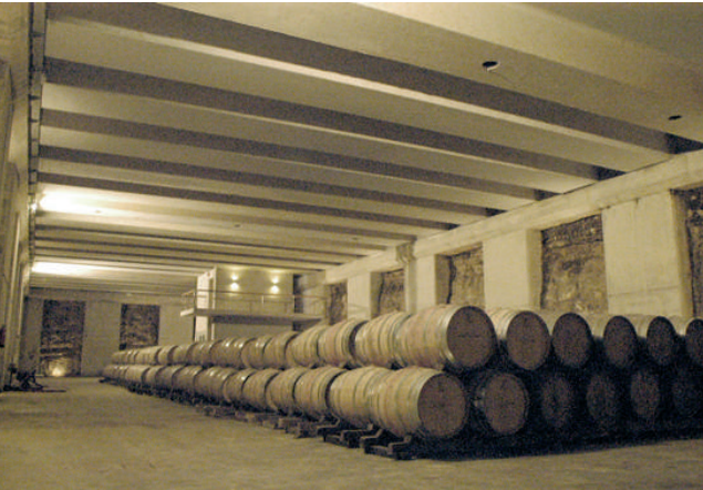
BODEGAS MURILLO VITERI. La Rioja. Forjado con sobrecarga de 2.500 kg/m 2 de sobrecarga en forjado, con luces de 15 m. Artlum 90.
