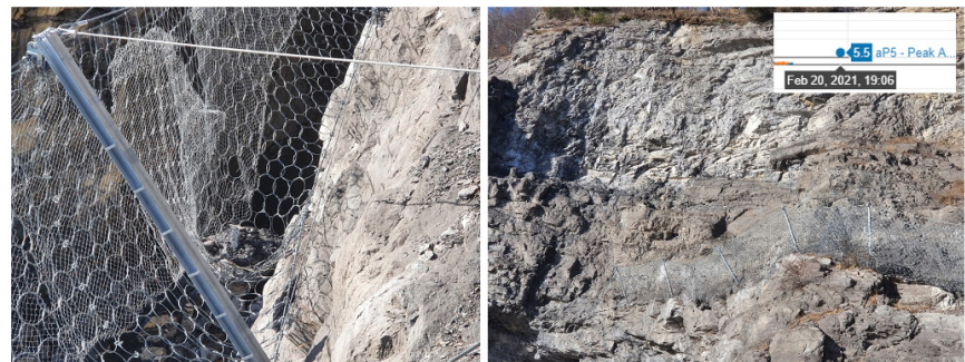
Fig. 17.- Impacto de aceleración 5,5 g sobre una de las barreras de apoyo a los ensayos de campo.
