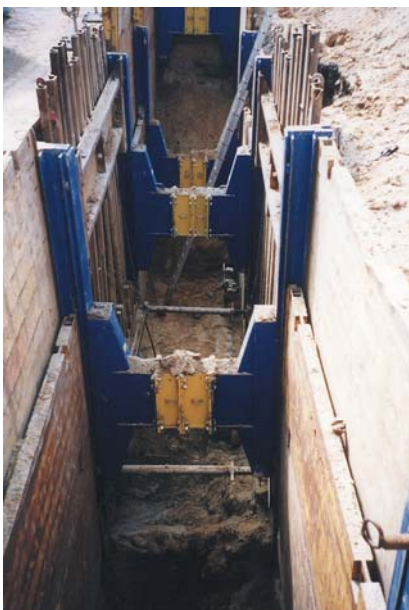
Cámara y tablestacas ligeras combinadas con el Monocodal de Patines.
