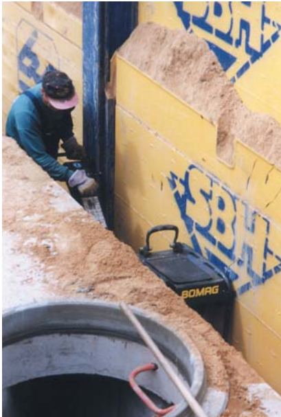
Compactación por tongadas.
