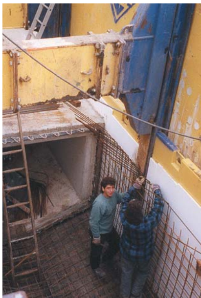
Deben protegerse con poliestireno expandido, antes del hormigonado "in situ".
