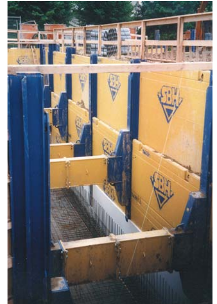
Las planchas son encofrado.
