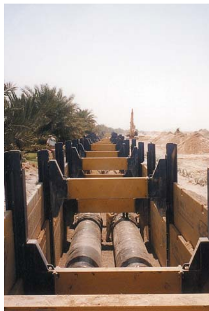
El colocar tubo de 10 m de longitud es posible con el Monocodal de Patines.
