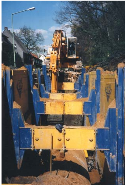
La excavadora funciona cómodamente.
