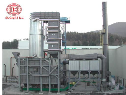
Caldera de aceite térmico de doble cuerpo de 10 Gcal/h, con cámara de combustión de parrilla móvil y descorificación vía húmeda
