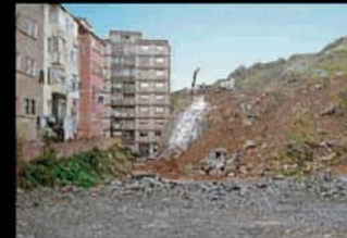
Desmonte entre edificaciones 6.800 m 3 Altura 13 m.
