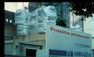
Vaciado entre viejas edificaciones.
