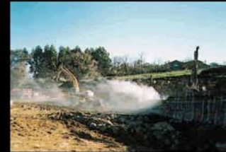
Gran desmonte 36.500 m 3 Altura 15 m.
