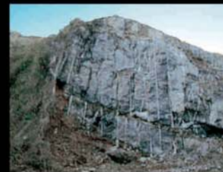
Desmonte entre edificaciones 6.800 m 3 Altura 13 m.
