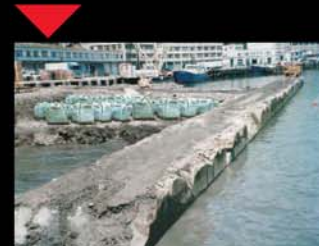
Muelle de Ondarroa 5.000m 3 Ø 70 Profundidad 9 m
