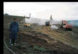
Gran desmonte 36.500 m 3 Altura 15 m.
