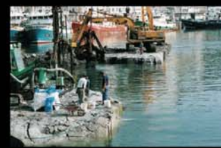
Muelle de Ondarroa 5.000m 3 Ø 70 Profundidad 9 m
