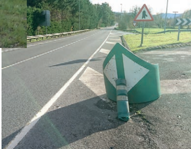
Barrera de contención deformada por impacto.
