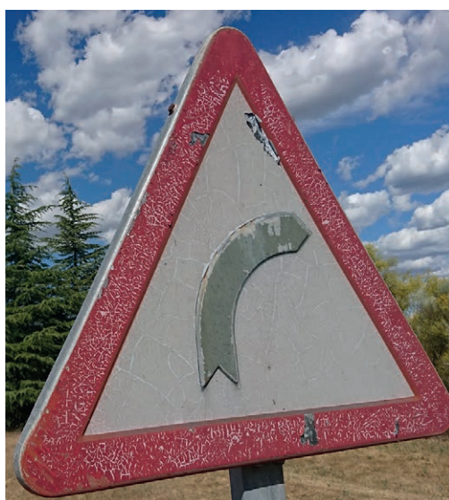
Señalización vertical deficiente: decolorada, cuarteada, pérdida de retrorreflexión, lámina despegada.
