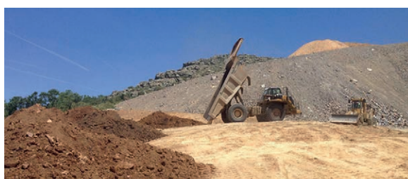
Fig 9. Retirada, acopio y extensión de tierra vegetal durante los trabajos de la fase de restauración. Fuente: Imagen cedida por Daytal Resources Spain, S.L.
