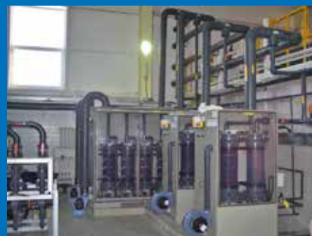
Instalación en edificio de obra civil
