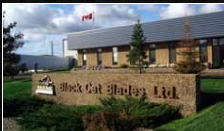
Edmonton Oficinas y Fábrica (Sede central)
