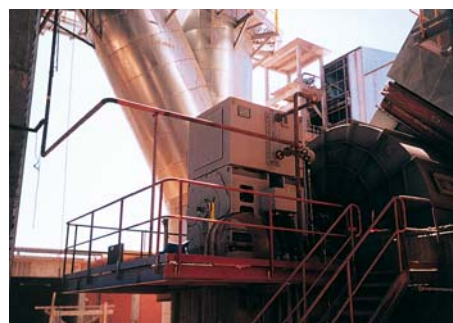
Motores CC con potencias desde 15 hasta 1400kW Aplicación: Extractores de Aire
