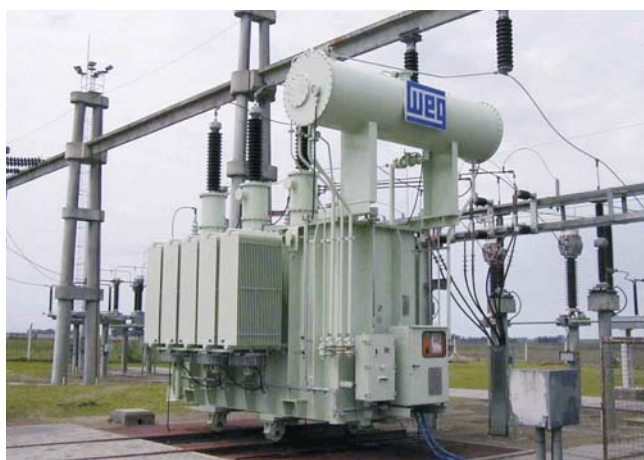
Energía de Entre Ríos S.A. - ENERSA (Argentina) Transformador de fuerza 30 MVA - 145 kV
