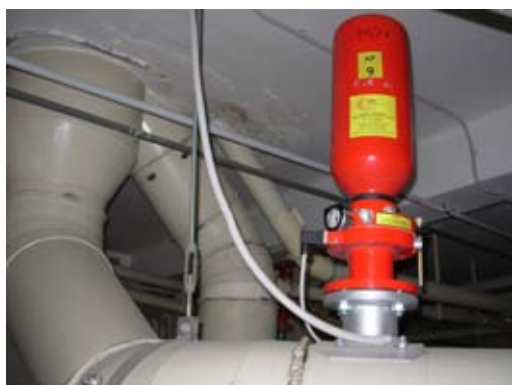
Barrera supresora en conductos
