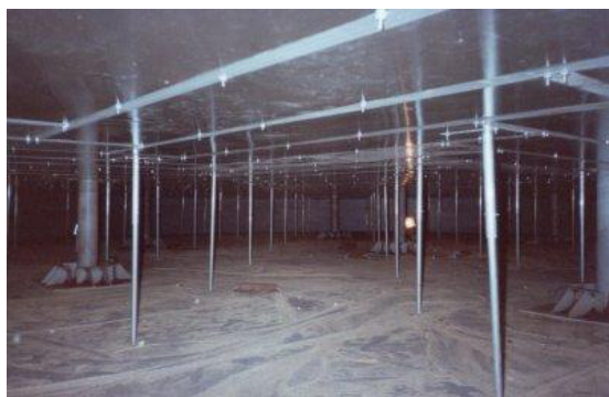
Techo flotante de aluminio, visto desde abajo
