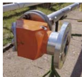
Apagallamas en línea angular
