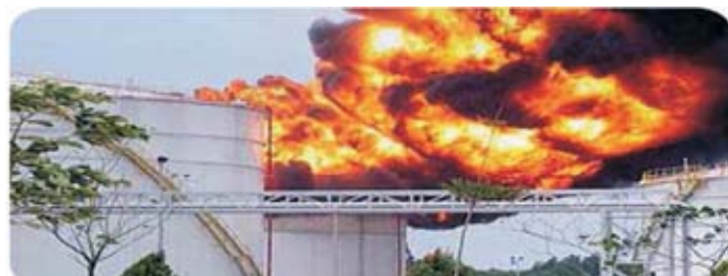
Tanque en llamas, sin sistema de extinción
