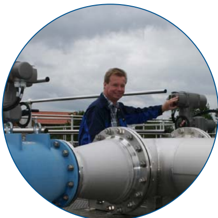
Fig. 3: El Director de operaciones Thomas Hutz controla periódicamente las nuevas válvulas de pistón anulares.
