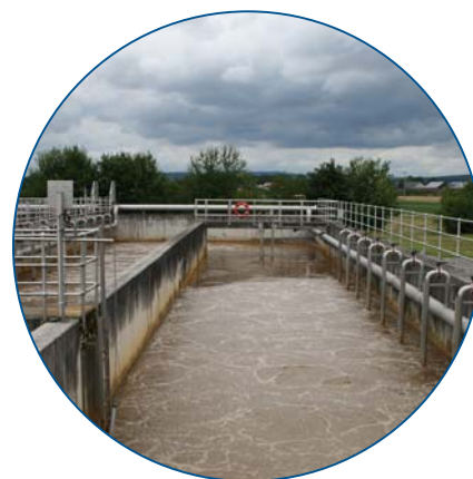
Fig. 2: Tanque de aireación en Markt Schwarzenfeld. Agua residual templada pero difícil.
