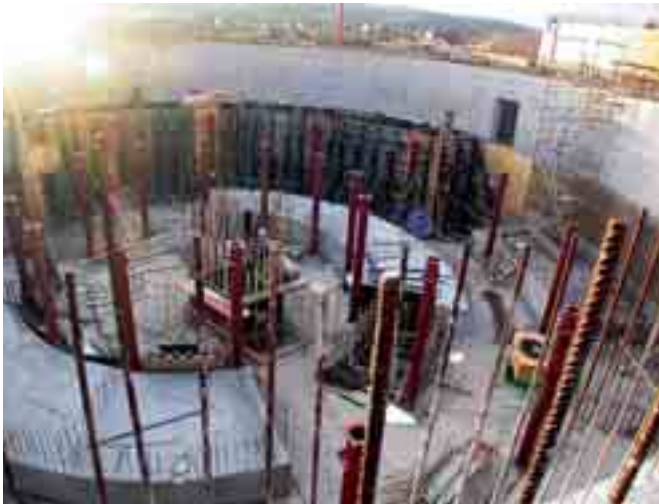
Cercha EUC 5,4 con encofrado BIRA
