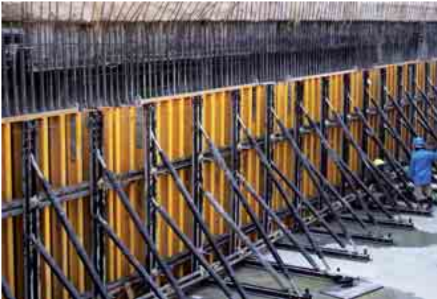
Riostras UCAB 3,3 con encofrado de forma ENKOFORM V-100
