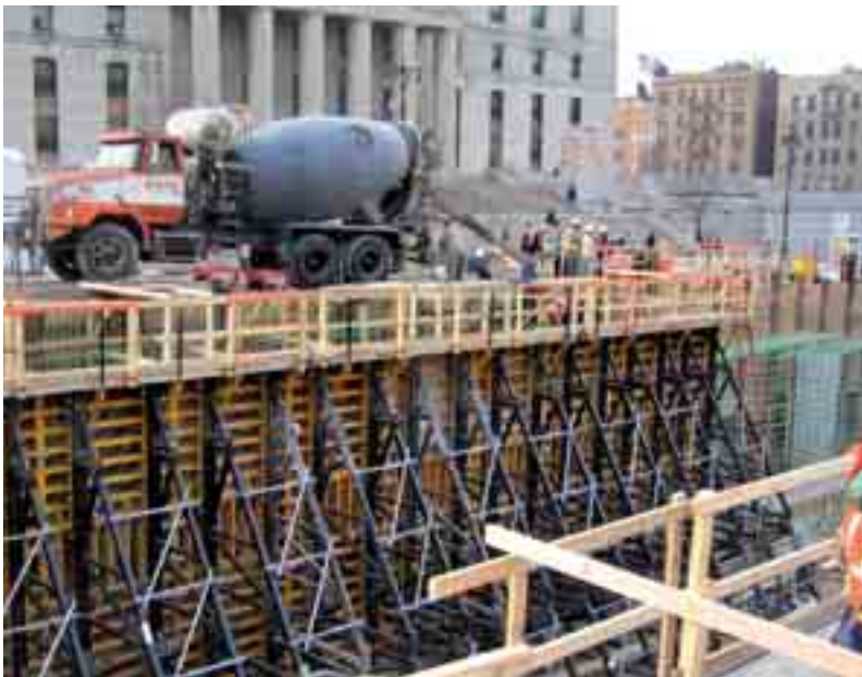
Cercha EUC 7,2 con encofrado MEGAFORM
