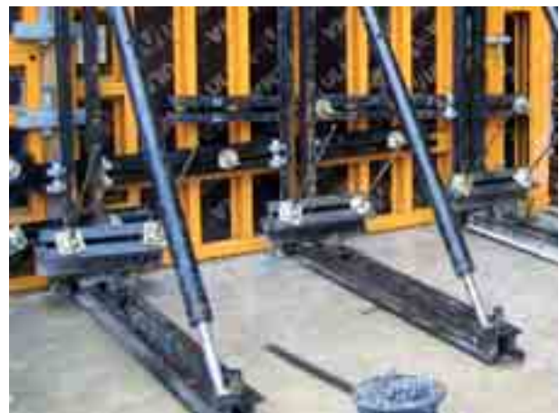
Anclaje del conjunto a la solera
