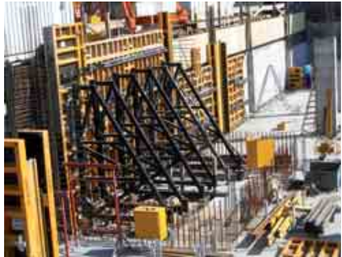
Cercha EUC 5,4 con encofrado ORMA
