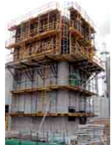
Consolas CM-220 con encofrado vertical ORMA
