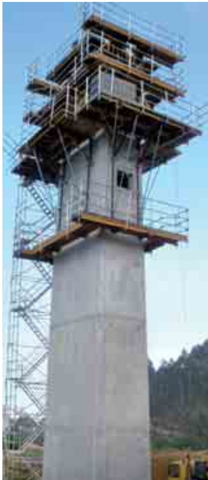
Consolas CR-250 en ejecución de pila, con plataforma de hormigonado, intermedia, principal y de recuperación de conos. El acceso se realiza mediante escalera de andamio BRIO
