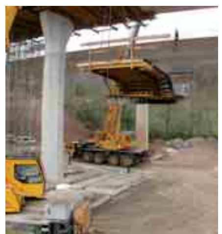
Desencofrado del tablero mediante grúa
