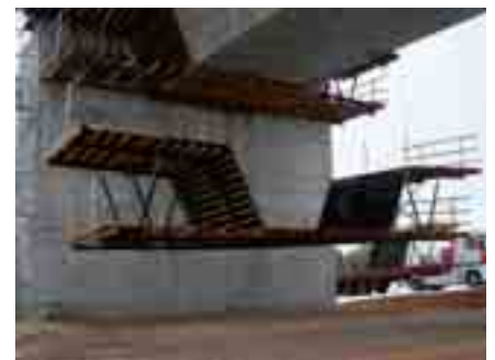
Desencofrado del tablero mediante tráctel
