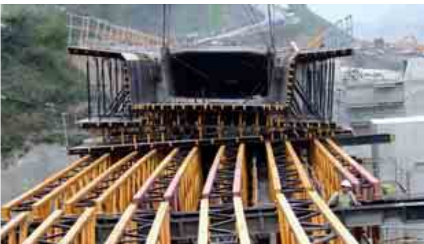
Ejecución de tablero con peralte
