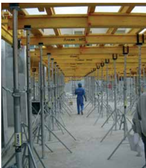
▲ Vigas VM-20 en el encofrado horizontal ENKOFLEX
