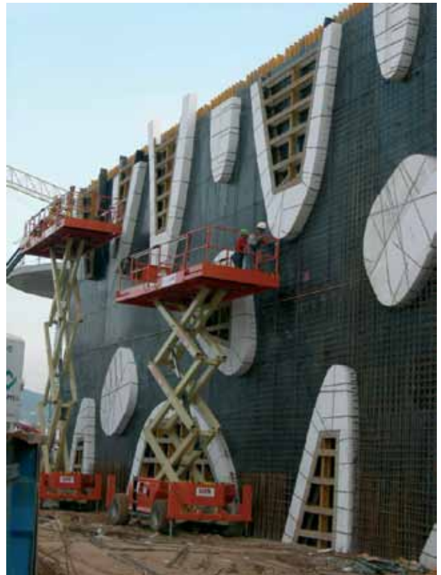
▲ Acabados de gran calidad en muros vistos obtenidos con el tablero fenólico en el encofrado vertical ENKOFORM V-100
