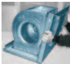
A l'extérieur positionnez la partie frontale 2, en introduisant la bouche du ventilateur A dans l'embouchure et fixer.
