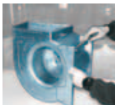
Monter les pieds B sur le ventilateur et positionner les bouts en caoutchouc (antivibratoires) C.
