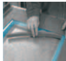
Pegar burlete de espuma de poliuretano en boca de impulsión.
