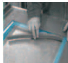
Entourer le raccord de la bouche d'impulsion d'un bourrelet de mousse en polyuréthane.
