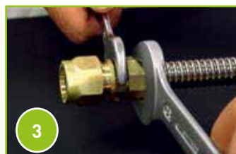
Apretar la tuerca hasta notar la resistencia
