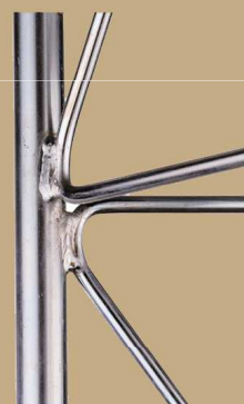
Detalle soldadura celosía
