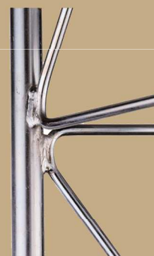
Detalle soldadura celosía
