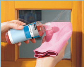
1) Limpiar las superficies de madera revestidas con el limpiador especial.
