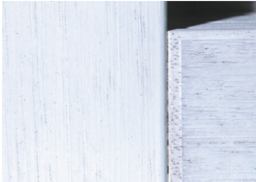
Entrada de humedad a través de una junta en V no tratada
