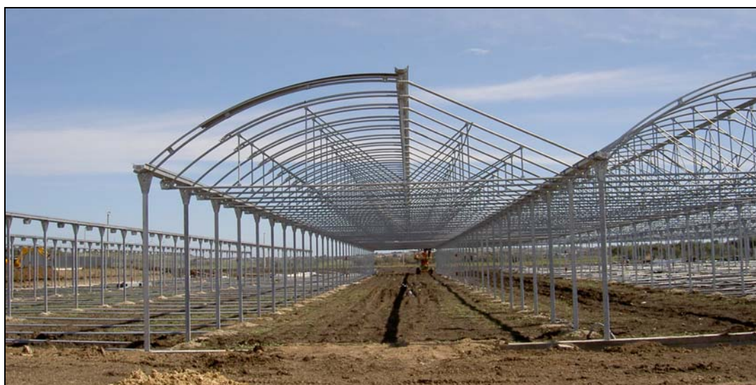
Vista frontal de una nave del invernadero P-9x4 Fotovoltaico.
