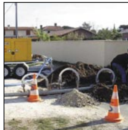
Sistema Wellpoint de bombeo por generación de vacío (Francia)
