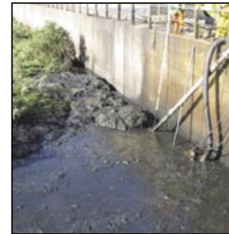
Limpieza de depósitos de sedimentación - Bomba trituradora (RU)
