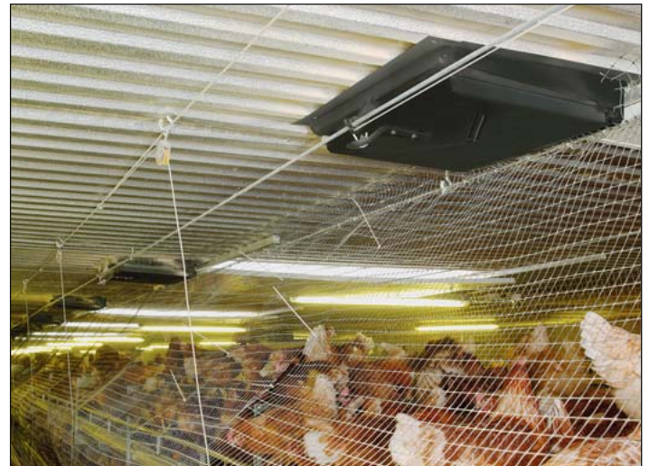
Uso de la CL 1800-N en sistema aviaro para la ventilación adicional en verano
