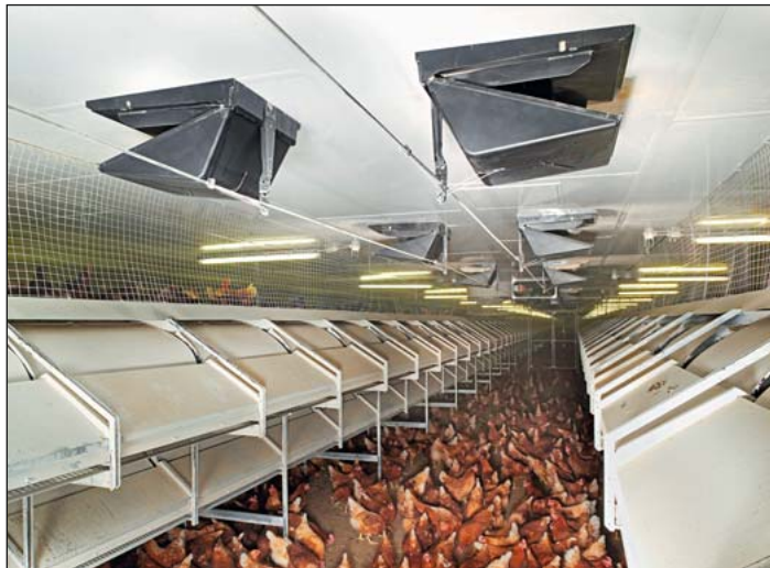
Uso de la CL 1500 en sistema aviaro para el suministro de aire fresco a través del espacio de techo
