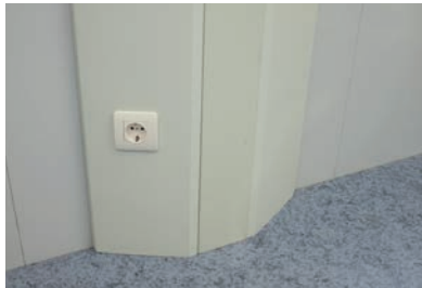
REMATERÍA INTERIOR DE FIJACIONES OCULTAS
