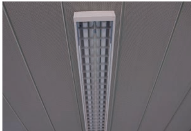
LUMINARIAS PHILIPS CON REFLECTOR 3 LUMINARIAS POR MÓDULO EM 500 LUX
