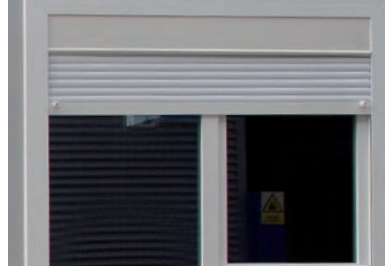
VENTANAS DE PVC DOBLE VIDRIO Y PANEL DE LANA DE ROCA 65 MM
