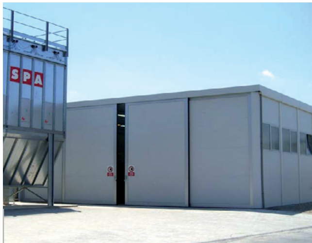
Nave de almacenaje en complejo industrial
