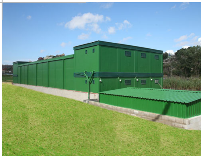
Nave multiusos en Club de Golf
