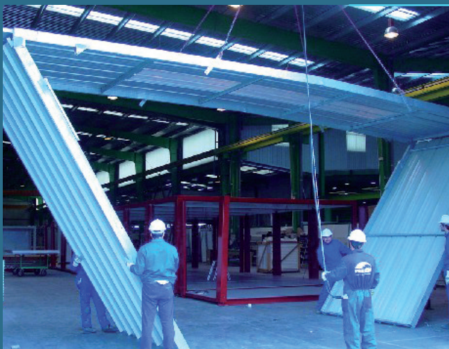
Montaje de una nave para almacenaje
