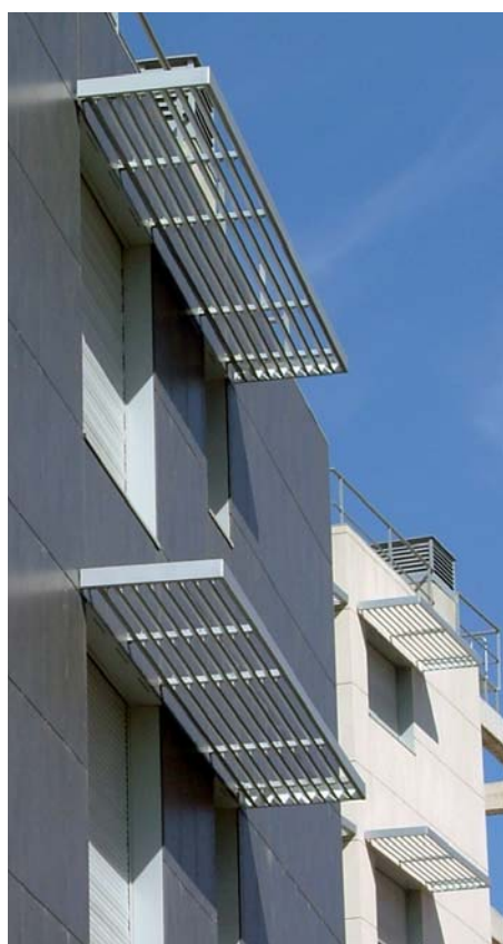
Sobre estas líneas, Pegalux de aluminio colocada tipo reja. Arriba, Pegalux de pvc en color Ral. A la derecha, Fijalux de pvc coloreada en Ral.
