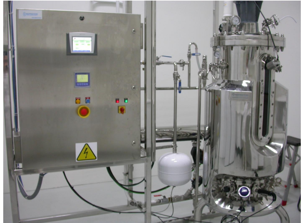
Cuadro de control
