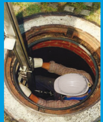
4. Entrada en el pozo
