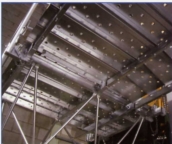
Extensibles con suelo de chapa de acero galvanizado Extensions with galvanized floor plates
