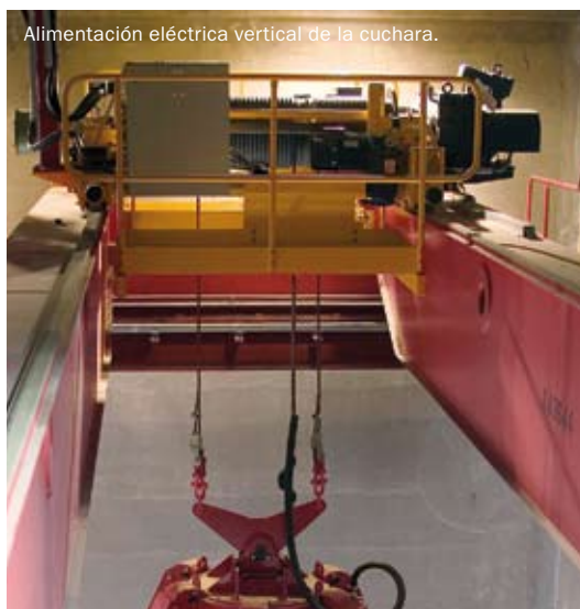
Lakeside, R. U., grúa para la manipulación de escoria de 10 t de capacidad.
