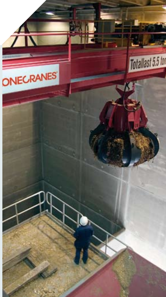
Londres, R. U., dos grúas Goliath de 25 t de capacidad para elevar contenedores de desechos desde barcas hasta camiones.
